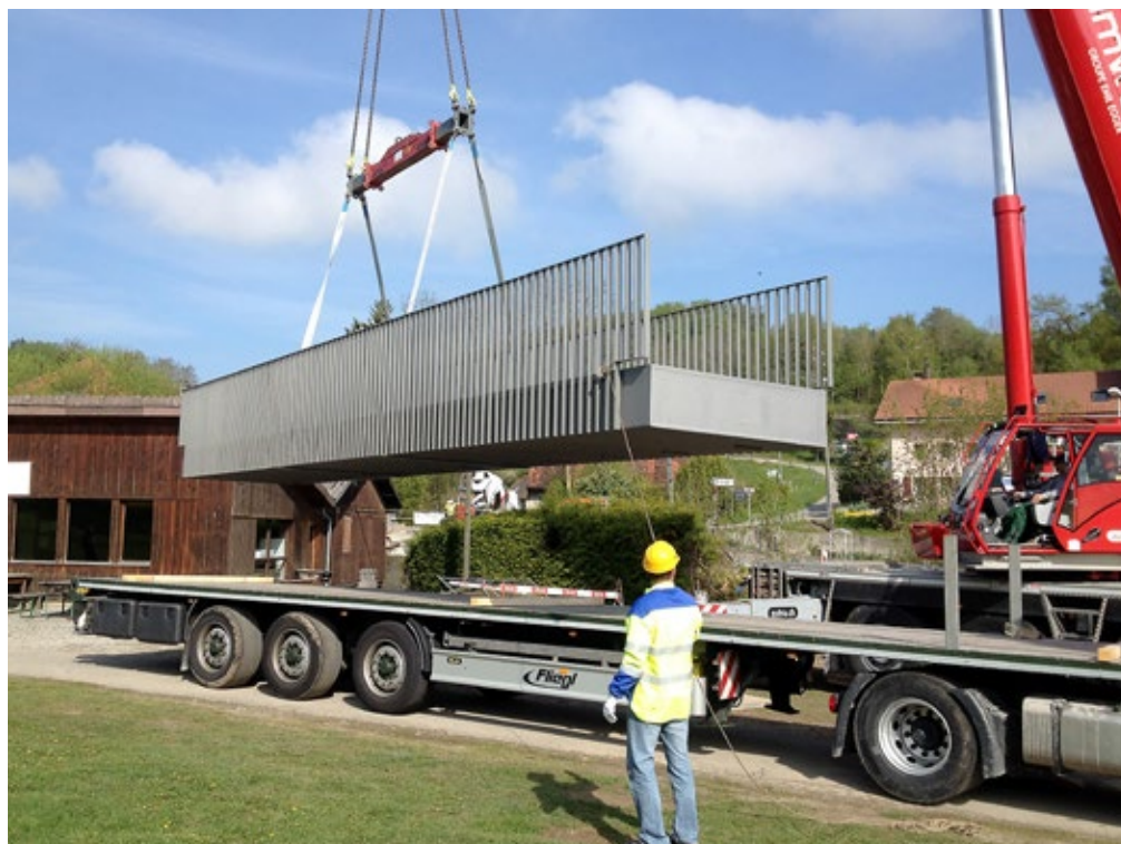
Installation einer typähnlichen Brücke mittels Mobilkran
