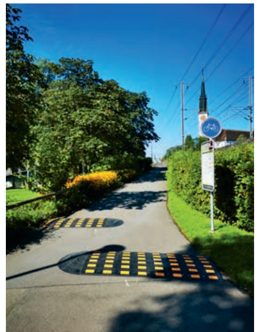
Veloweg beim Hirsgarten Richtung Bahnhof mit Tempobrechern
