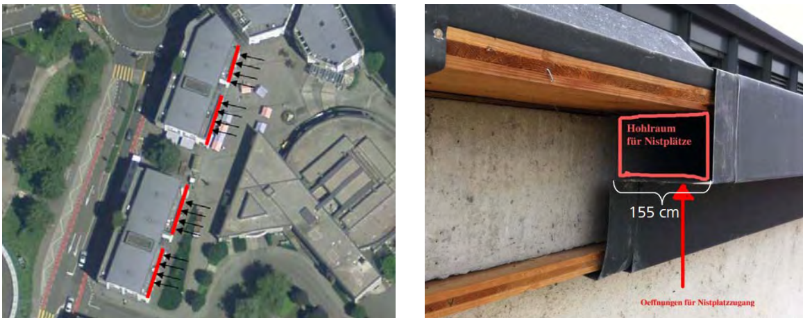
Abb 8: An den Gebäuden am Dorfplatz brüten Mauersegler. Im Rahmen einer diesjährigen Fassadenrenovation wurde im Einverständnis des Eigentümers auch gleich mit einer einfachen Lösung das Angebot an Nistplätzen für diese Vogelart ausgebaut. Dabei wurde ein bestehender Hohlraum der Blechverschalung der Traufuntersicht der Attikabalkone durch einbringen von Öffnungen für diese Vögel zugänglich gemacht.
