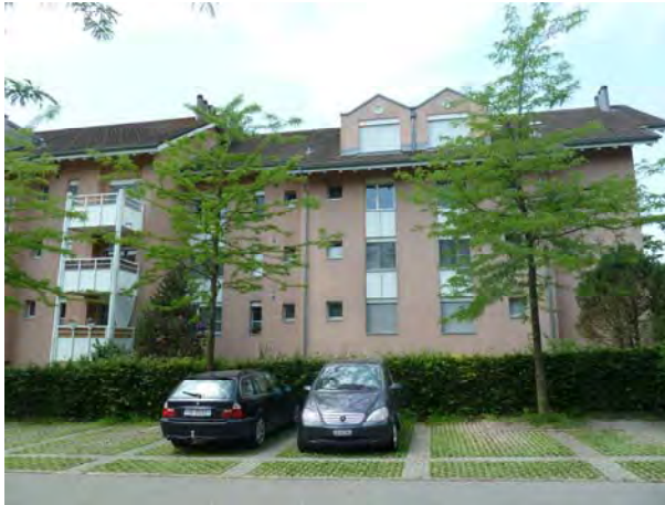
Siedlung Langackerstrasse, Friesencham
