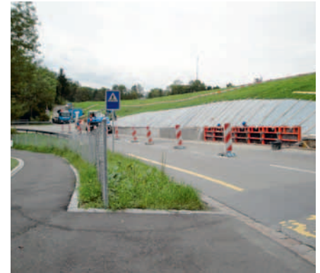
Baustelle Mitte September 2012
