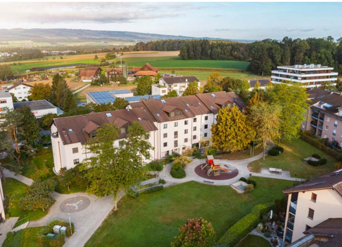
Langackerstrasse, Liegenschaften im Miteigentum der Gemeinnützigen Baugenossenschaft Cham
