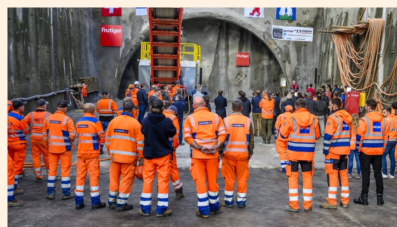
Mit der Anstichfeier startete der Bau des Tunnels Städtlerwald für die Umfahrungsstrasse, 18.10.2024
