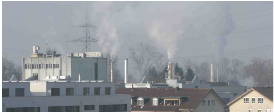
Blick von Südosten in Richtung Löberen/Teuflibach
