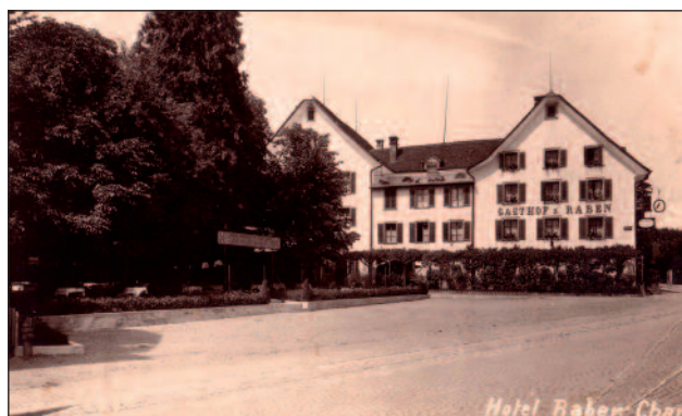
Der «Raben» mit seinen zwei Gebäuden: zur Linken mit Gartenbeiz.
