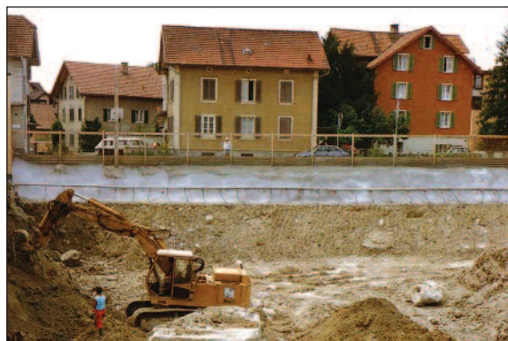
Baustelle Neudorf: Hier entstand das neue Zentrum.
