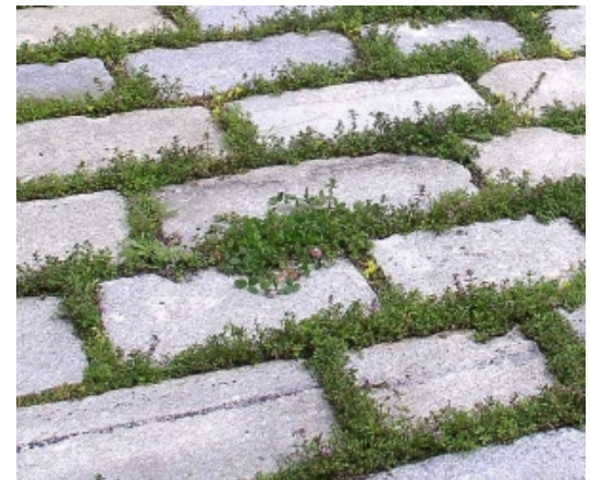
Natursteinpflasterung mit offenen Fugen
