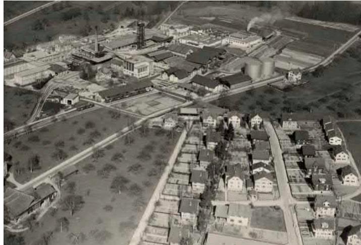
Papierfabrik, Cham, Comet Photo AG / ETH-Bibliothek Zürich, ca. 1964.
