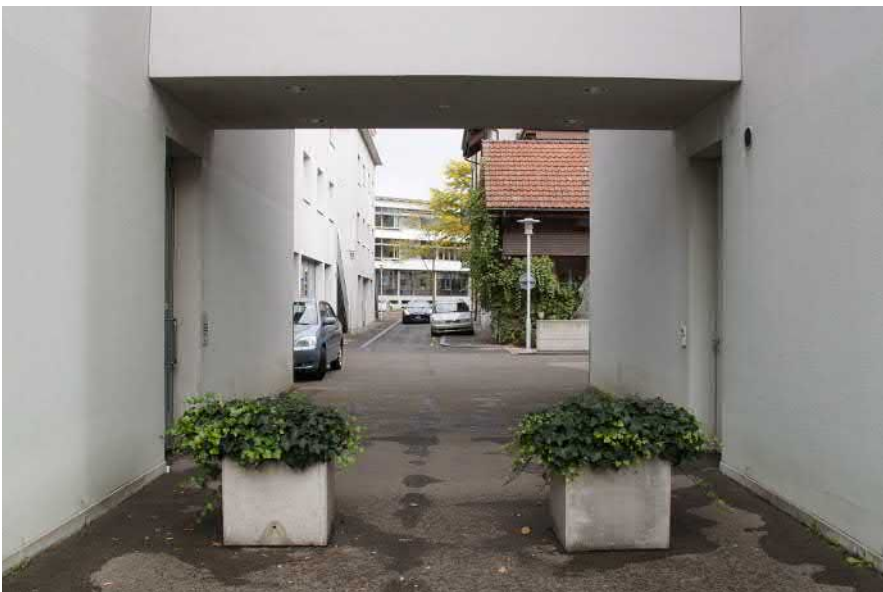
Zugerstrasse, Cham – Bild: Futurafrosch, 2019.
