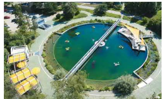
Z. B. ein Klärbecken als Wohlfühloase. Kläranlage, Zürich.
