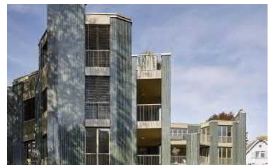
Z. B. Grossformen mit Freiraumbezug. Wohnbauten Steinwiesstrasse, Zürich – EMI Architekten.
