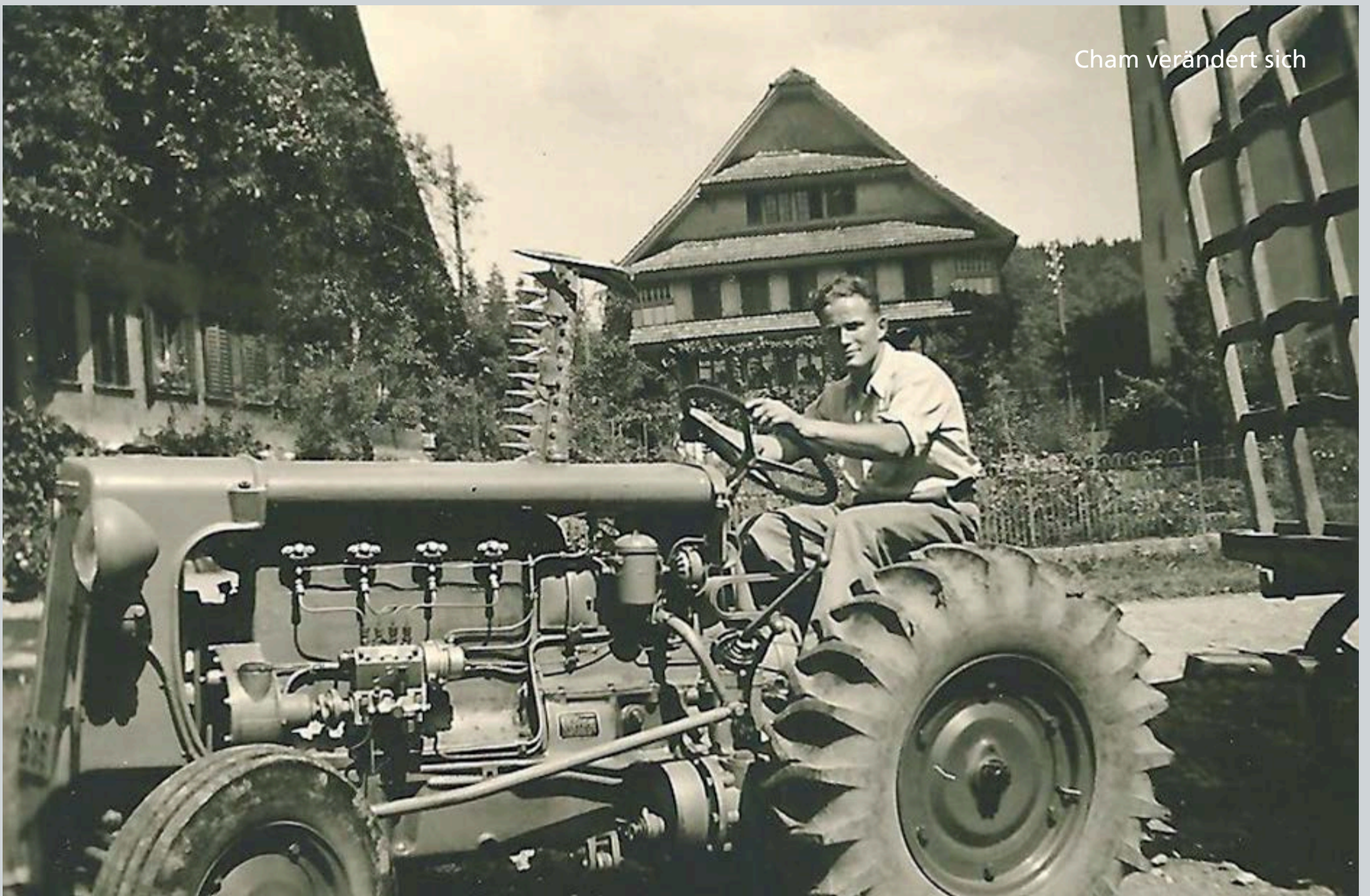
Hinten steht das Kaplanenhaus: Doch das Bild entstand für den Bauern.
