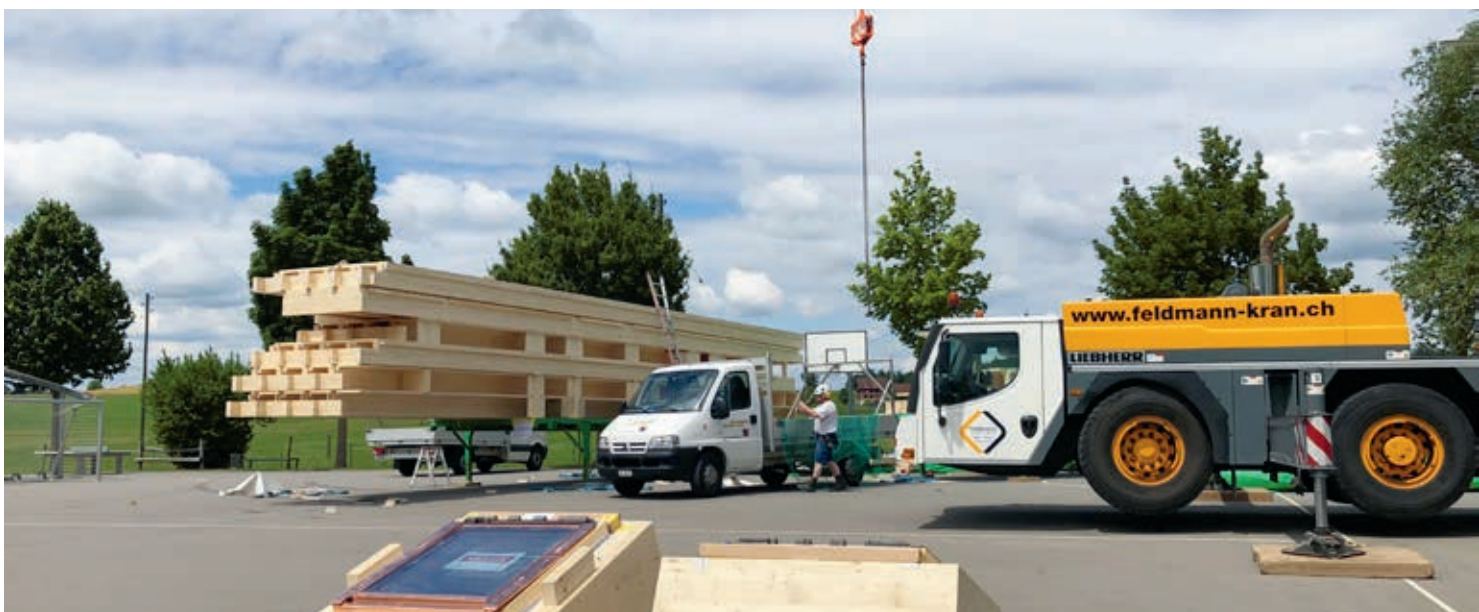
Holzelemente Neubau/Sanierung Schulhaus Niederwil
