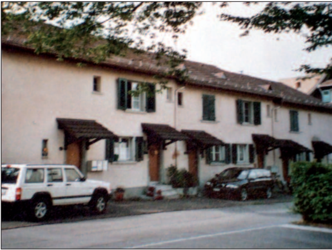
Ursprünglich ohne Vordächer: Die Reihenhäuser der Papierfabrik.
