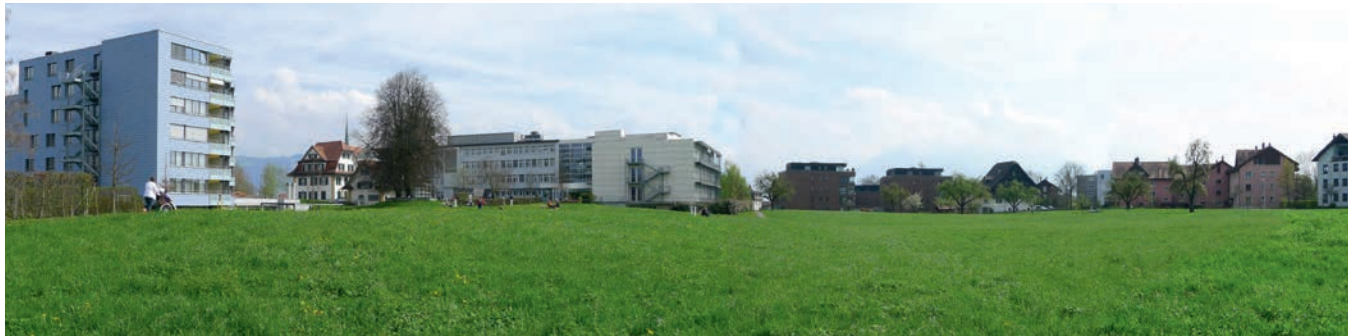
Panoramafoto Häuserzeile Richtung Süden 180°
