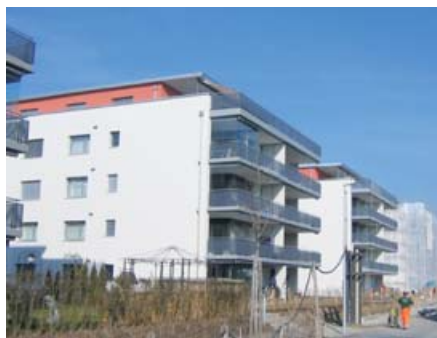
Wohnüberbauung «Rütiweid» im Eizmoos mit 90 Wohnungen.
