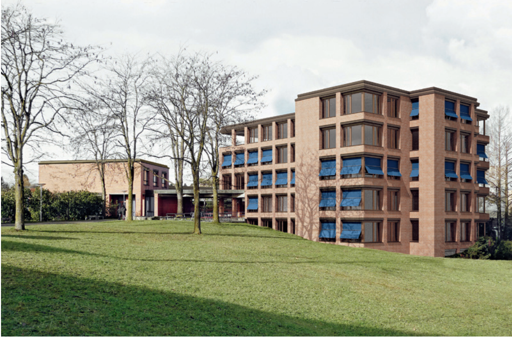
Aussenansicht der Erweiterung Schulanlage Röhrlberg I
