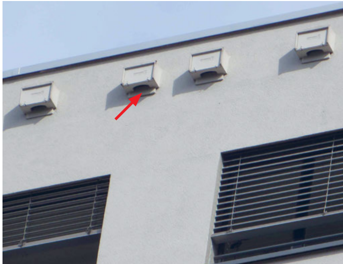
Eingebaute Nisthilfen für Alpensegler.
