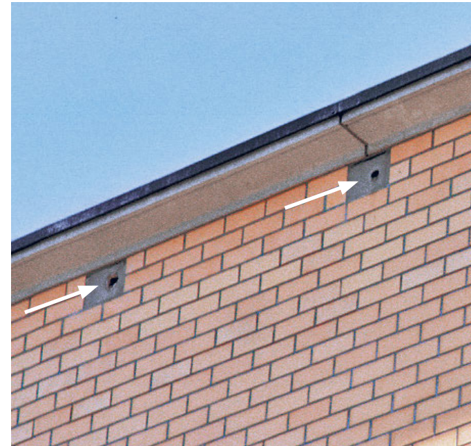
In die Fassade eingelassene Niststeine.
