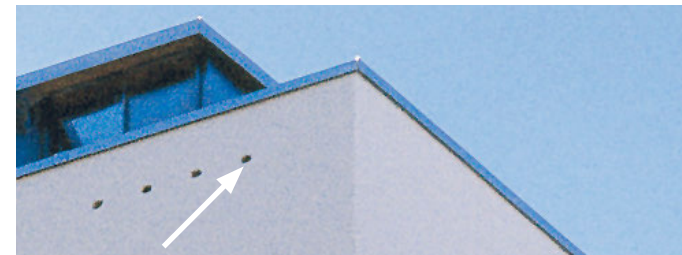
Fertiggestellter Neubau mit eingebauten Seglernistplätzen.
