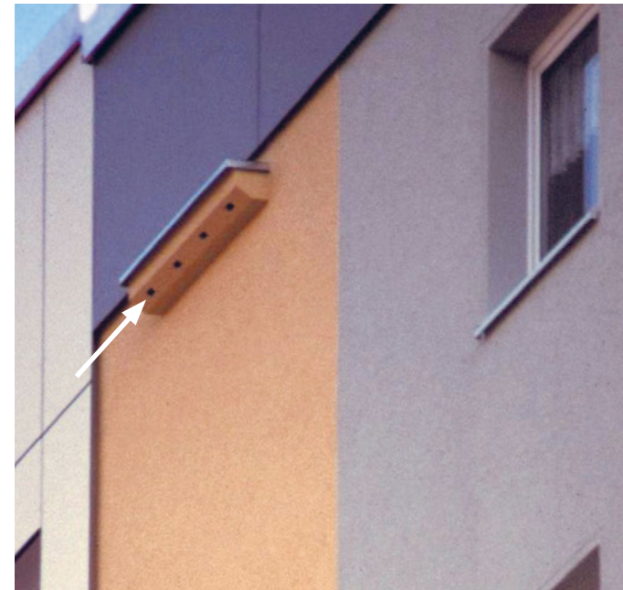
Dem Gebäude angepasster Nistkasten für Mauersegler bei einem Neubau. (Bild: J. Börner, Chemnitz)
