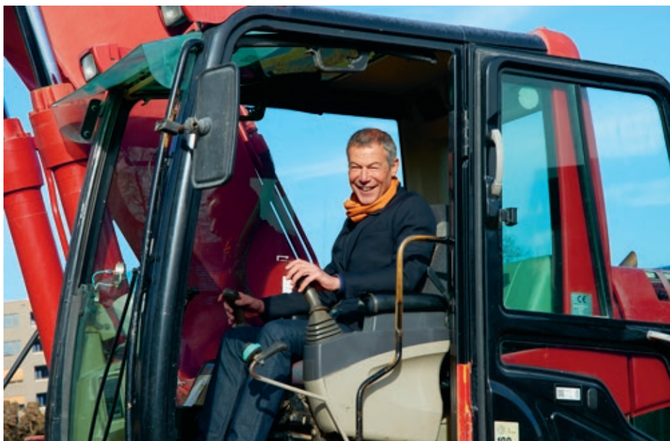
Dr. Urs Karli, Direktor der AndreasKlinik Cham Zug, hat gleich selbst mit dem Aushub des Parkhauses Rigistrasse begonnen. Foto: Claudia Fagagnini
