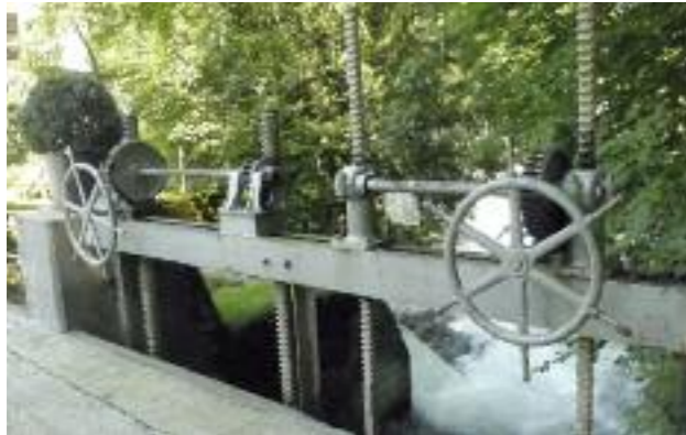
Stauwehr Hammerschmiede (Eisenhammer)
