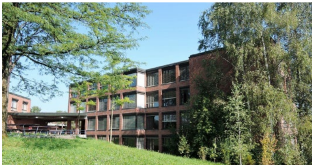
Aussenansicht Südost des Schulhauses Röhrliberg I
