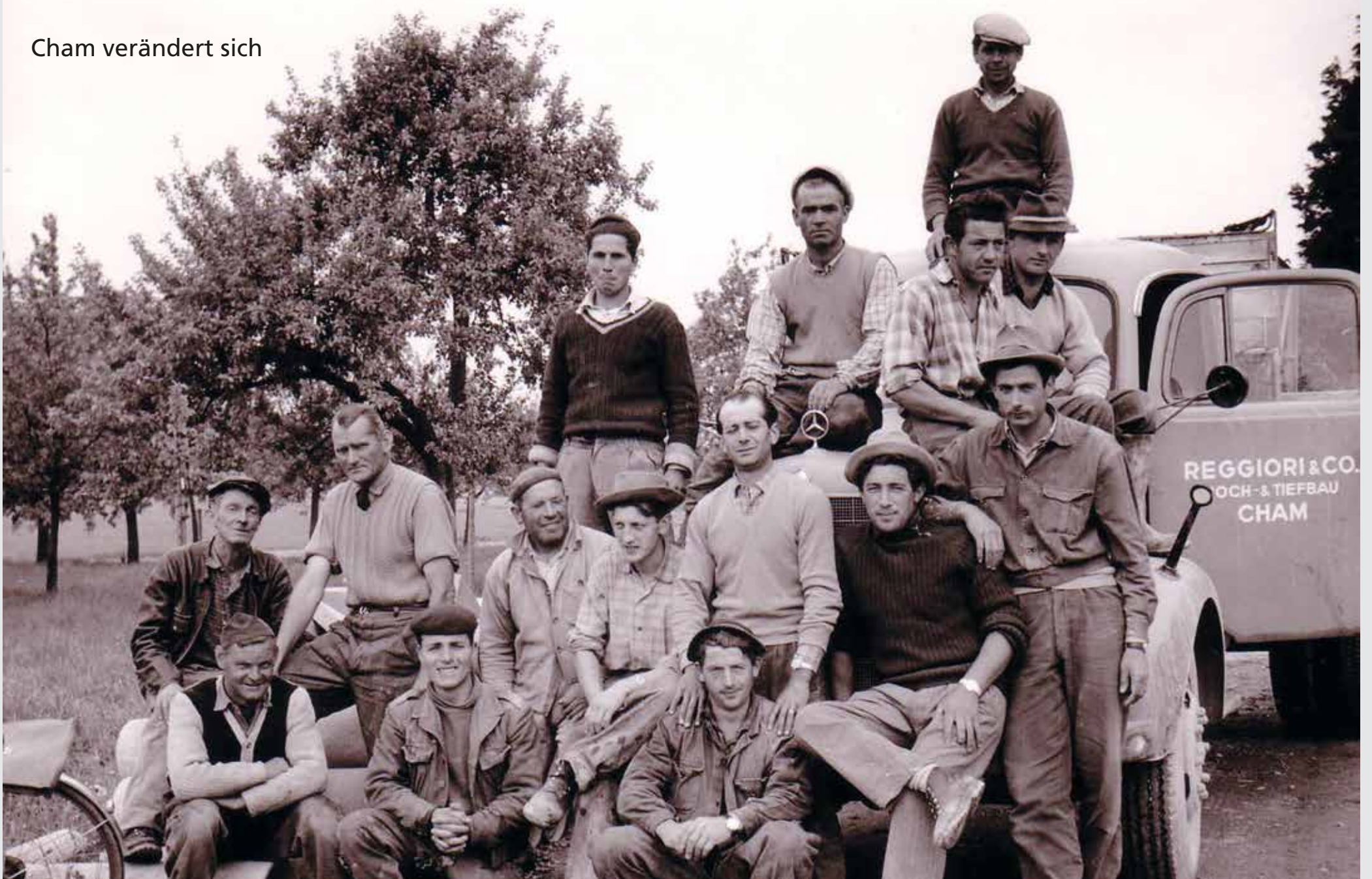
Kräftige Kerle: Arbeiter der Firma Reggiori, die 1961 den Spitalanbau in Cham realisierten.
