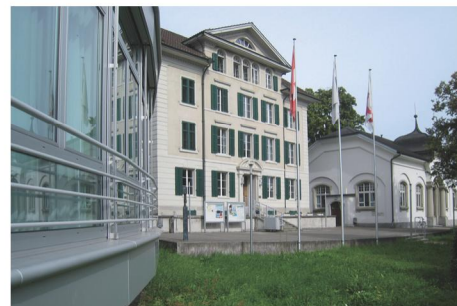
Mandelhof, altes Gemeindehaus und alte Turnhalle im Zentrum von Cham
