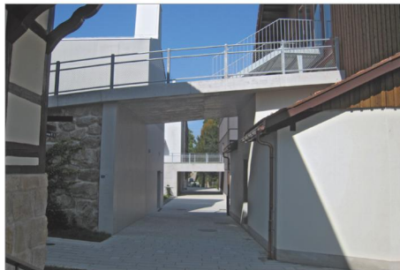
Stützmauern sind eine Gestaltungsaufgabe (Hammergut)
