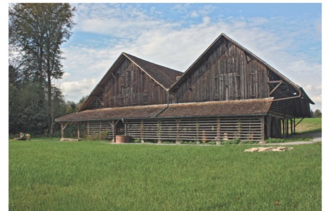
Mit geneigten Dächern können auch grosse Bauten in die Kulturlandschaft eingebunden werden (Alte Ziegelei)
