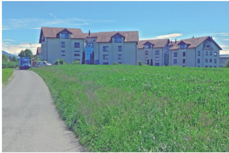
Zustand: Der Siedlungsrand beherrscht den Landschaftsraum (Allmendweg)
