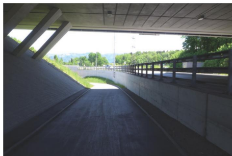
Licht am Ende des Tunnels - Blickverbindung aus der Autobahnunterführung (Kreisel Sinslerstrasse)
