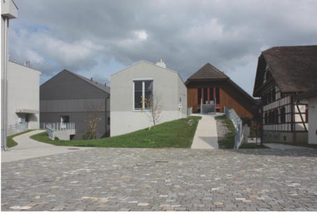
Alt und Neu aneinanderggebaut (Hammergut)
