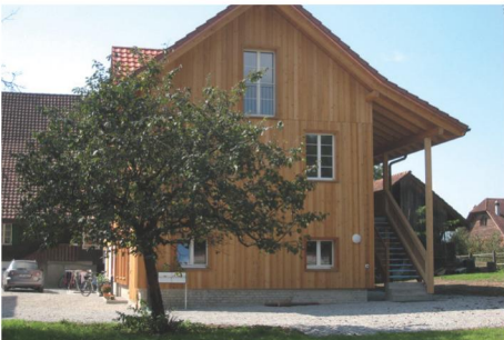
Umbau ländlicher Wirtschaftsbauten
