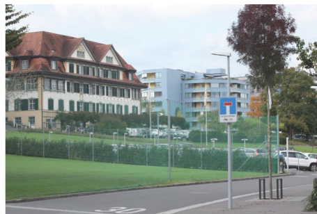
Andreasklinik: Lage im Park – oder im Parkplatz?
