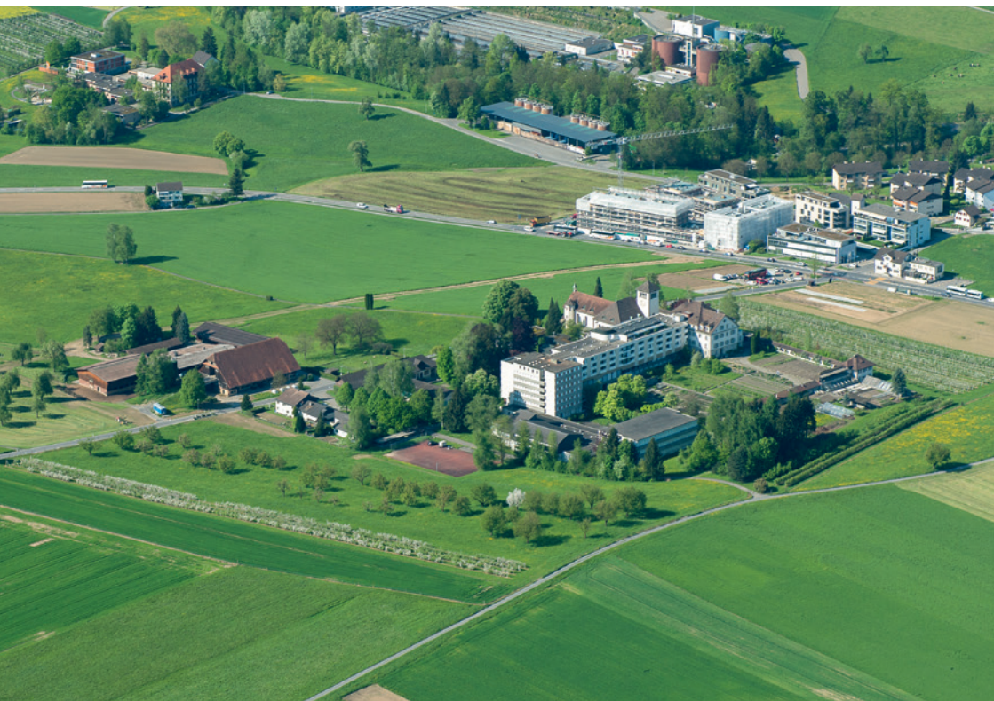
Ansicht von Süden, im Vordergrund die nicht mehr genutzten Gebäude.
