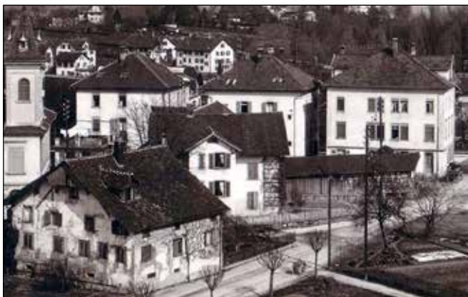
Die Häuserzeile von hinten: vorne das Haus Doswald, hinten die drei Gebäude an der Luzernerstrasse.
