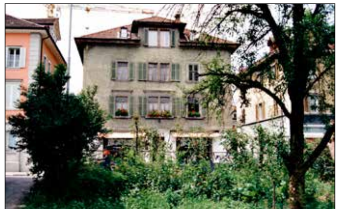
Die frontale Ansicht von der gegenüber liegenden Seite der Luzernerstrasse: mit dem «Kreuz» links und dem Haus von Kleider Widmer rechts. (Foto: Heidi Cabernard)
