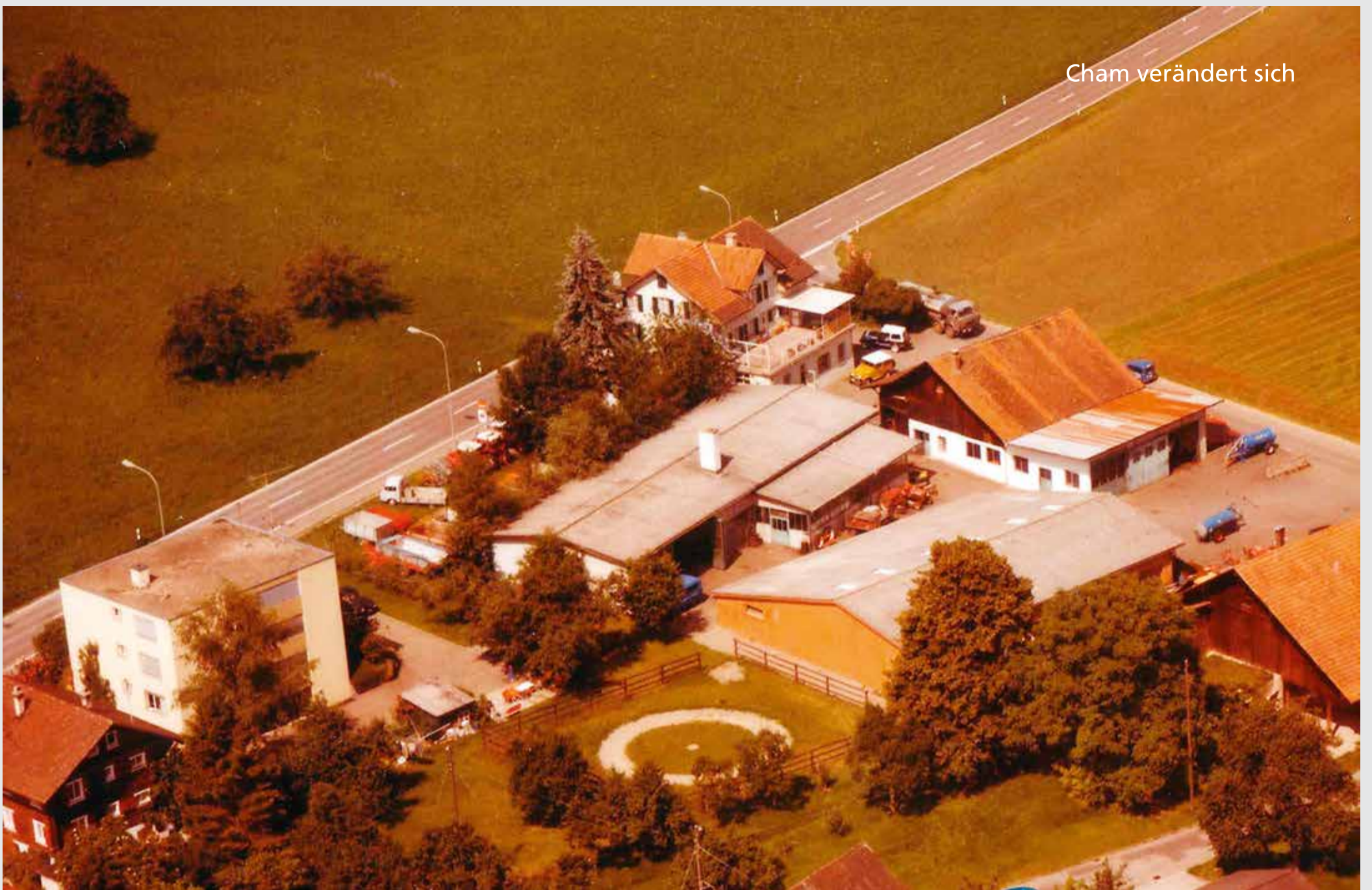
Die Schmitte (weisses Gebäude Mitte oben) mit ihren Nebengebäuden: Luftaufnahme aus den 1980er-Jahren.
